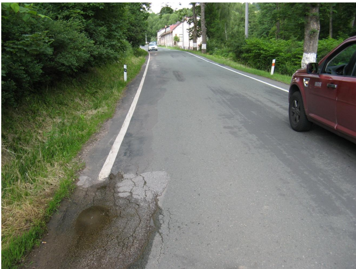
F62, km 26,410+ Opotřeбенý EKZ, místní pokles vlevo a dále síťové trhliny podél okraje vozovky.
