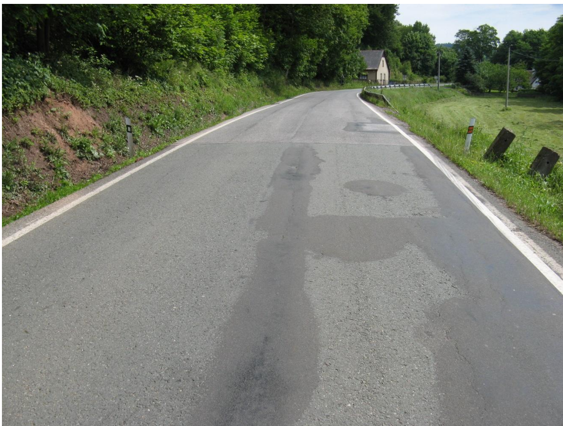
F40, km 25,610+ Vpravo síťové trhliny.
