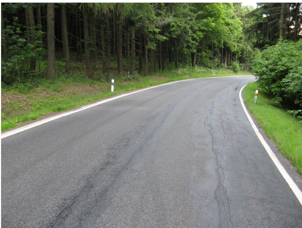
F94, km 28,800- Síťové trhliny.
