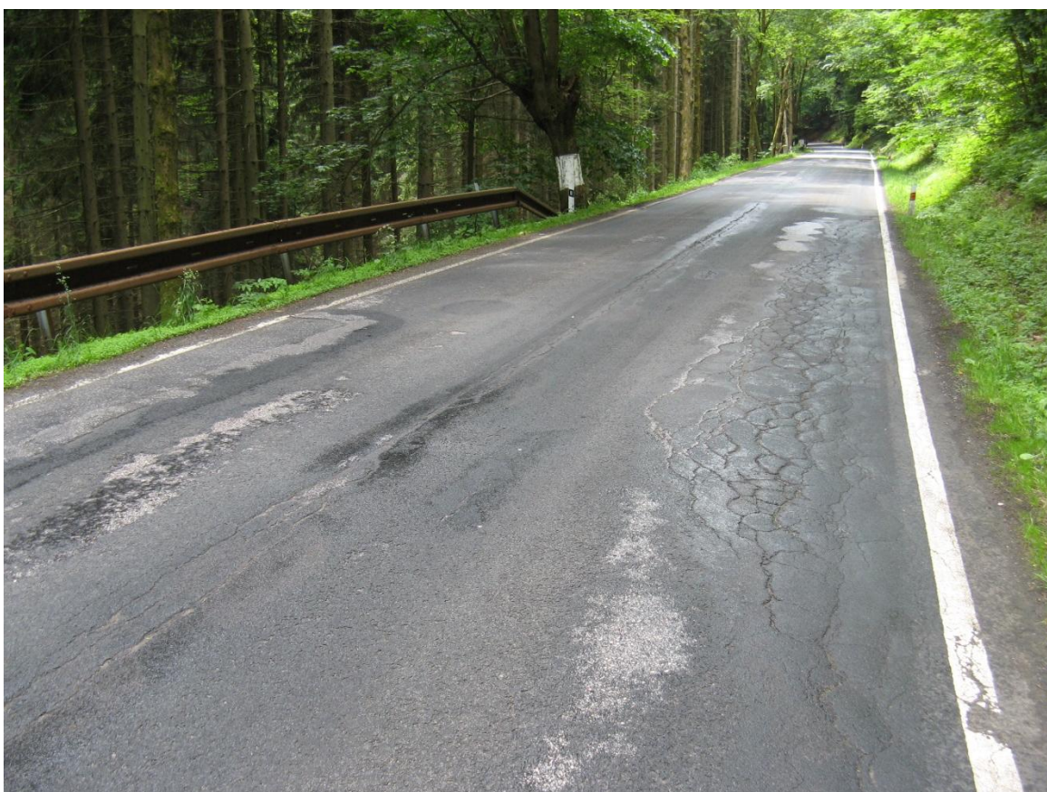
F104, km 29,700- Síťové trhliny.
