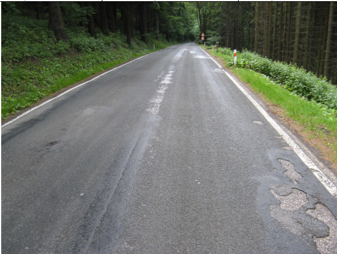
F99, km 29,110+ Vlevo mírné deformace podél okraje, vpravo výtluky.
