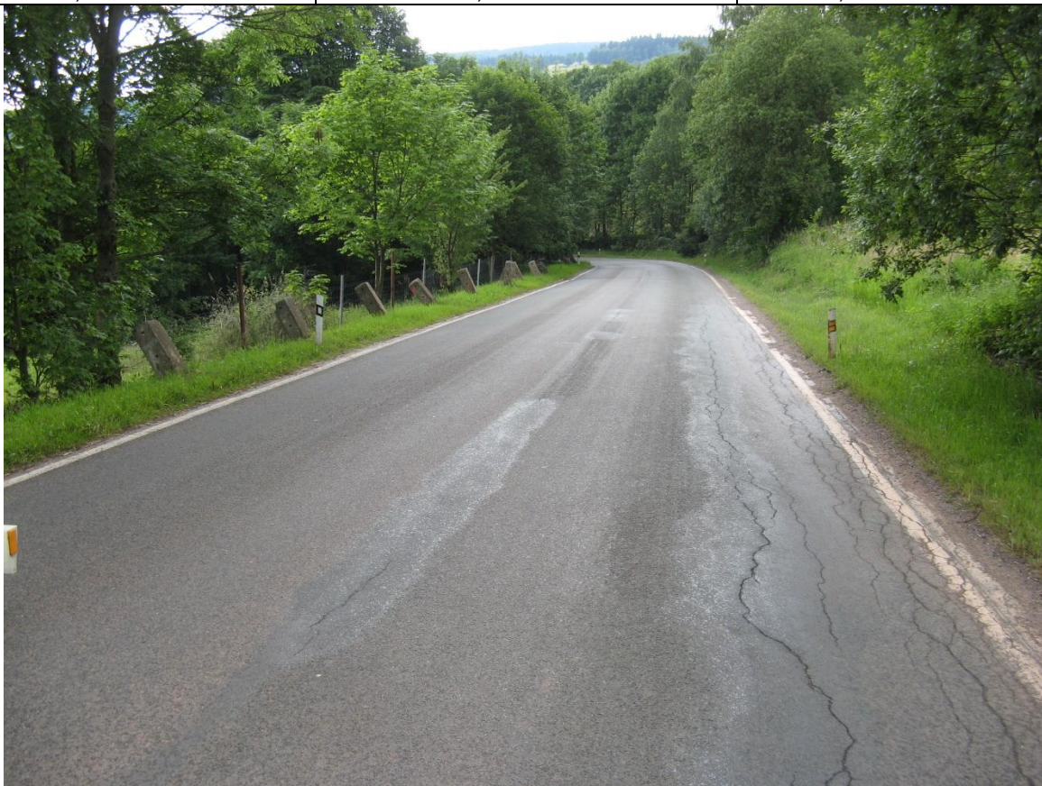
F90, km 28,500- Síťové trhliny.
