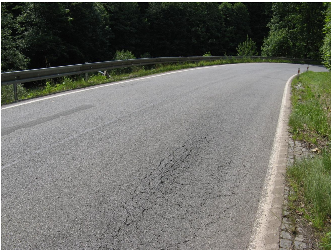
F24, km 24,600- Část s opraveným povrchem, lokální síťové trhliny.
