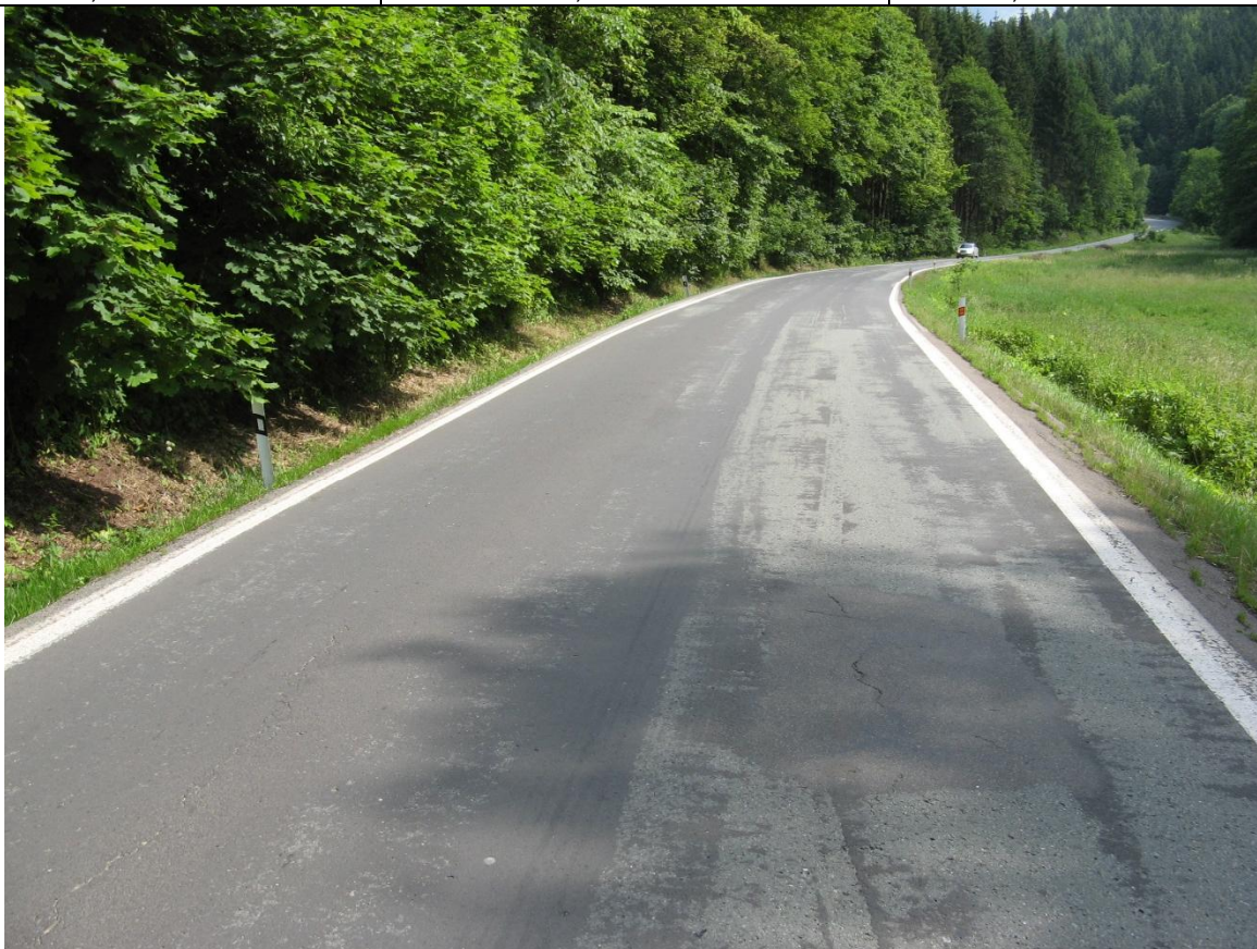
F18, km 24,210+ Povrch s opotřebeným EKZ.
